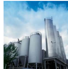
nora systems_Schritt 0_Werk Weinheim_Silos
