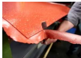
nora systems_Schritt 5_Endbearbeitung norament_1
